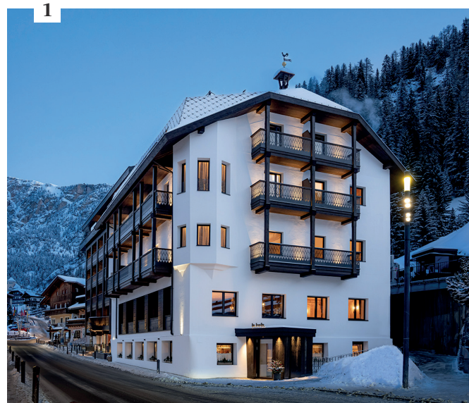
1. The renovated façade. La facciata rinnovata.
