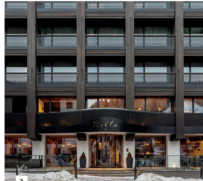
2. The main entrance. L'ingresso principale.
